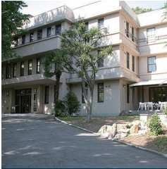
■表紙写真「大阪大学待兼山修学館」 1931年に大阪帝国大学医学部附属病院石橋分院本館として、待兼山に竣工。その後、医療技術短期大学の校舎として使用されていたが、2007年に総合学術博物館に改修した。約600点に及ぶ学術標本資料や発明品、歴史資料などが展示されている。中でも豊中キャンパスから発掘された約50万年前の「マチカネワニ」の化石は有名。レトロなステンドグラスがはめ込まれた建物は、2008年に国の登録有形文化財に指定された。
